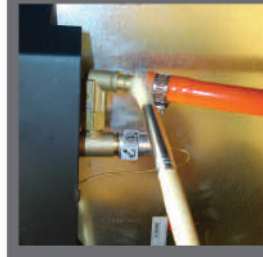
Anslutning av slangen till kaminen
